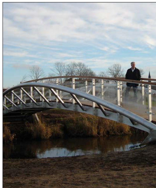
Virksomhederne LØ-MA og BELØ har bygget bro til fremtiden. Broen er bygget i aluminium, selv om virksomhederne ikke tidligere havde arbejdet med aluminium.
